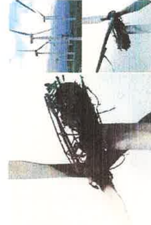
仁賀保高原風力発電所
