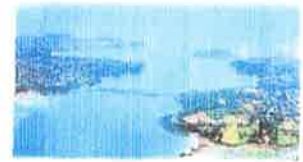
リン・マロの潮力発電所（フランス）
