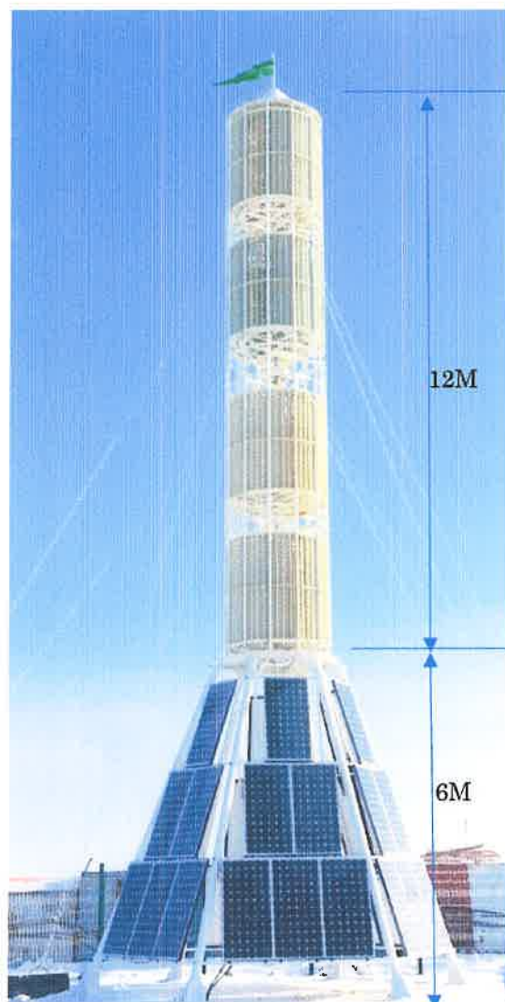
ハイブリッド発電装置の発電容量 (15kw) カザフスタン国 Almaty 市
