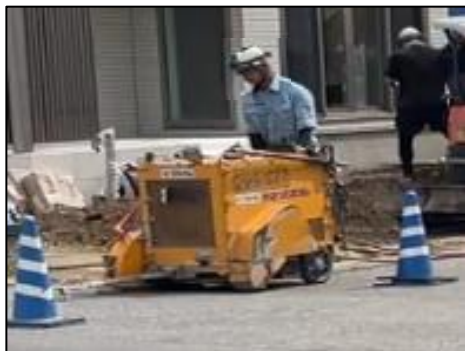
舗装切断（カッター）
