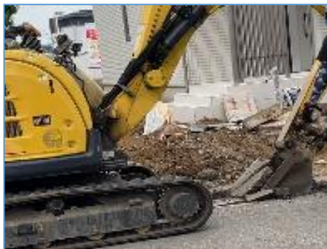
舗装除去（バックホウ）
