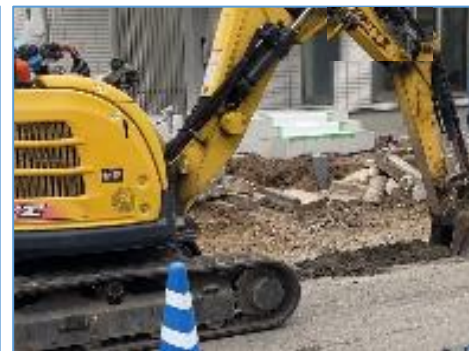
本掘削（バックホウ）
